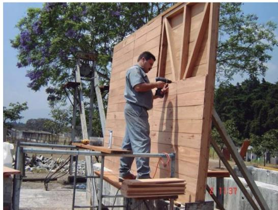
**Nota.** Proceso de construcción de muro de madera para su ensayo. Tomado de *Implantación de un sistema de control de calidad en la edificación de muros utilizando maderas nacionales* (Ayala, 2006).
