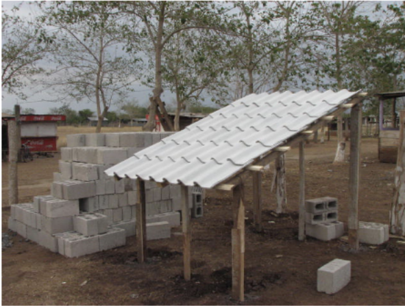
Figura No. 4. Muestra de cubierta de teja de micro concreto
